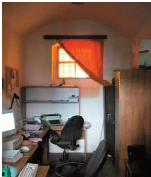
Abb. 26 Farbreflexion der gegenüberliegenden Hausfassade mit kräftigem gelbem Anstrich – im Wachzimmer wird das Tageslicht gelb verfärbt
